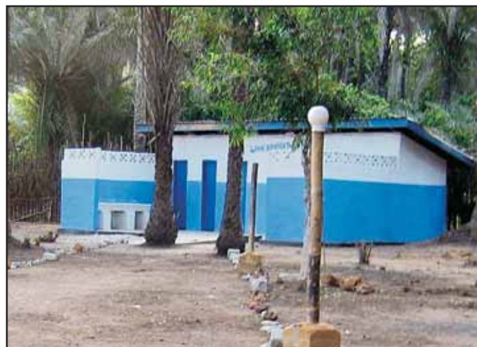
Servizi igienici esterni
